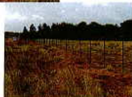
Photo de la clôture
